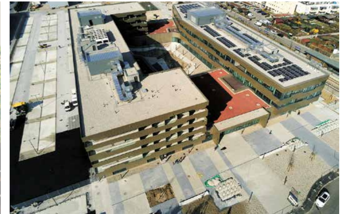
Beim Bildungscampus der Österreichischen Bundesbahn in St. Pölten ist das Know-how der Bauüberwacher gefragt
