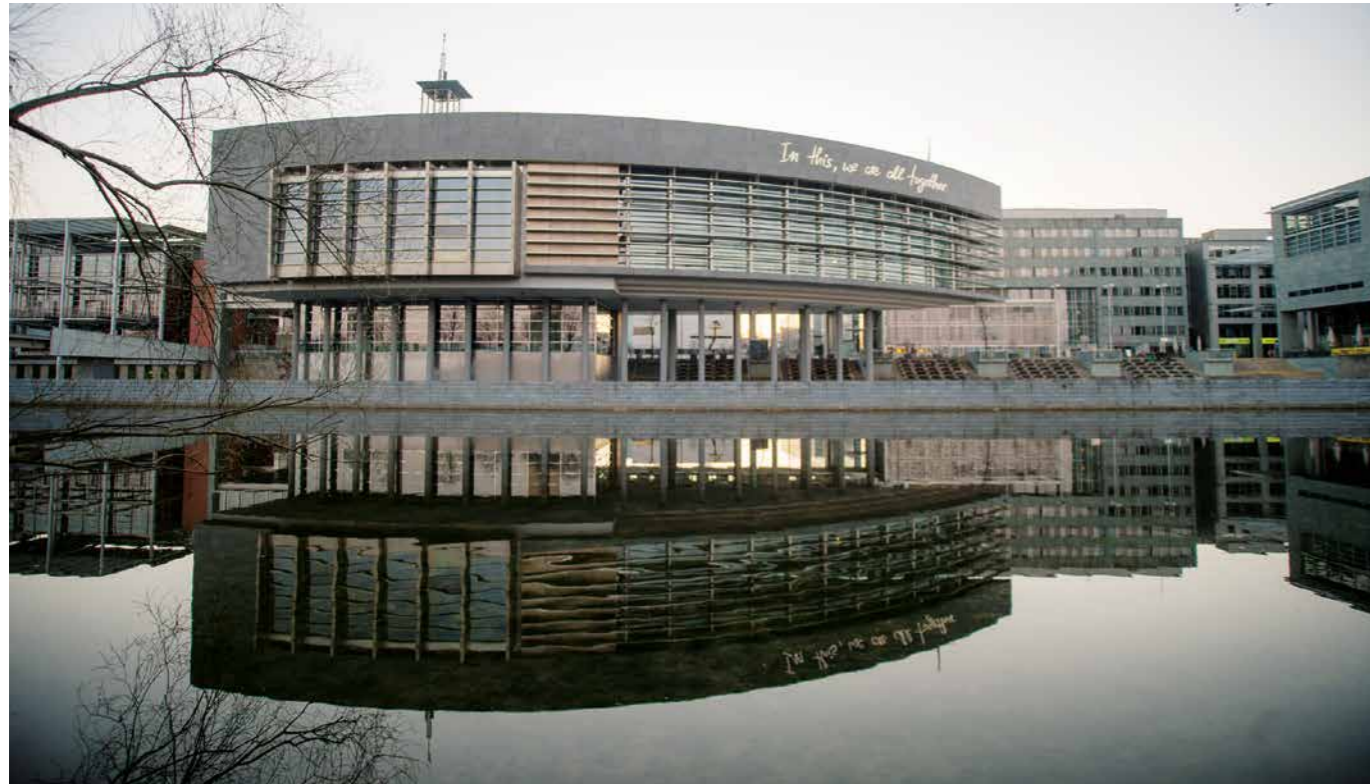
KWI hatte die fachtechnische Bauleitung für die gesamte Haustechnik beim Bau des Niederösterreichischen Landhauses in St. Pölten
