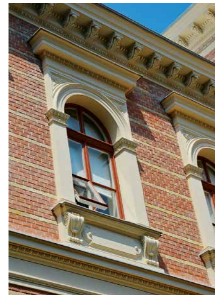
Die Fassadensanierung der historischen Universitätssternwarte in Wien plante KWI
