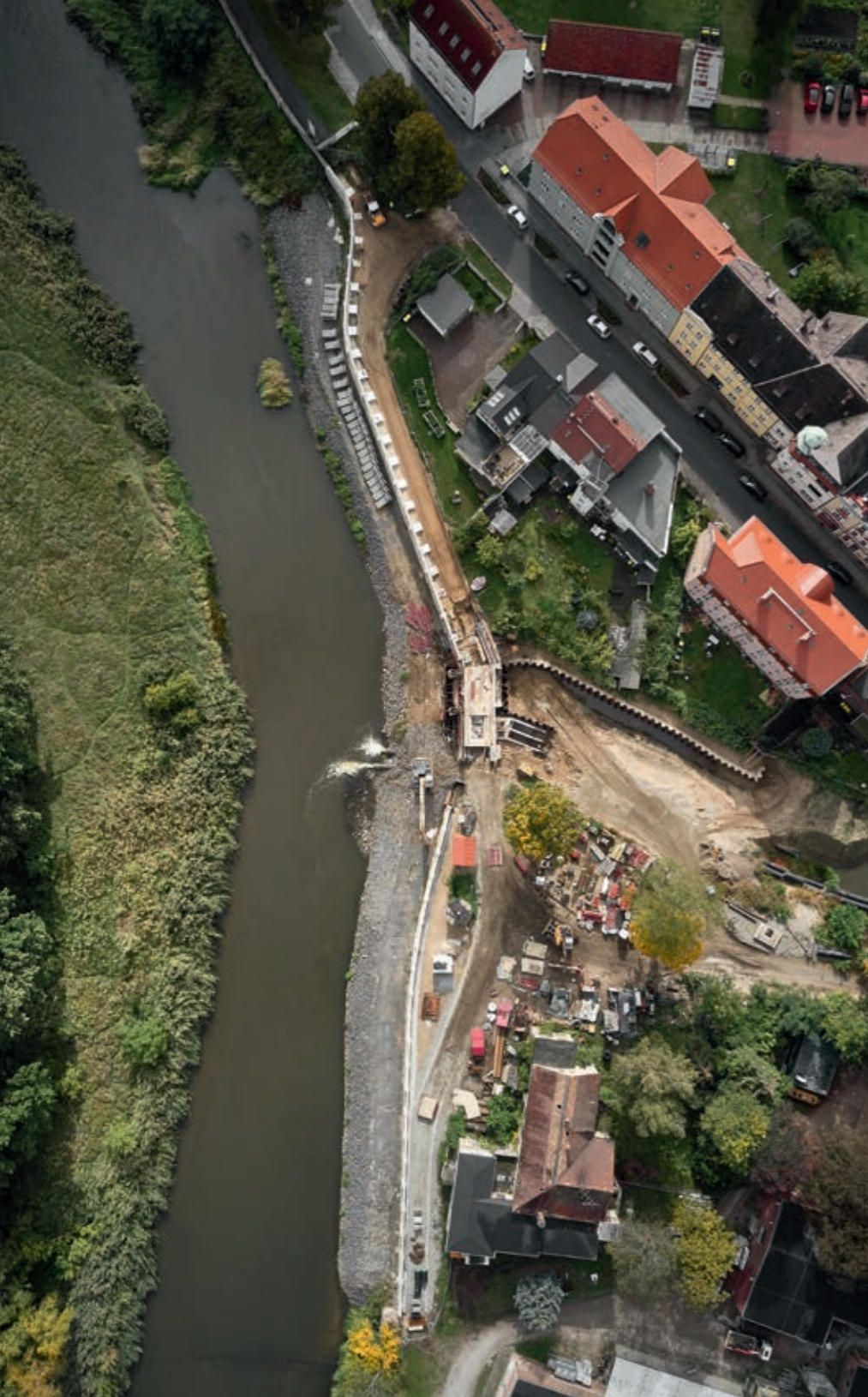
↑ Von rechts kommt die Egelneiße, an deren Mündung eine Fischaufstiegsanlage und ein Auslaufbauwerk entstanden
