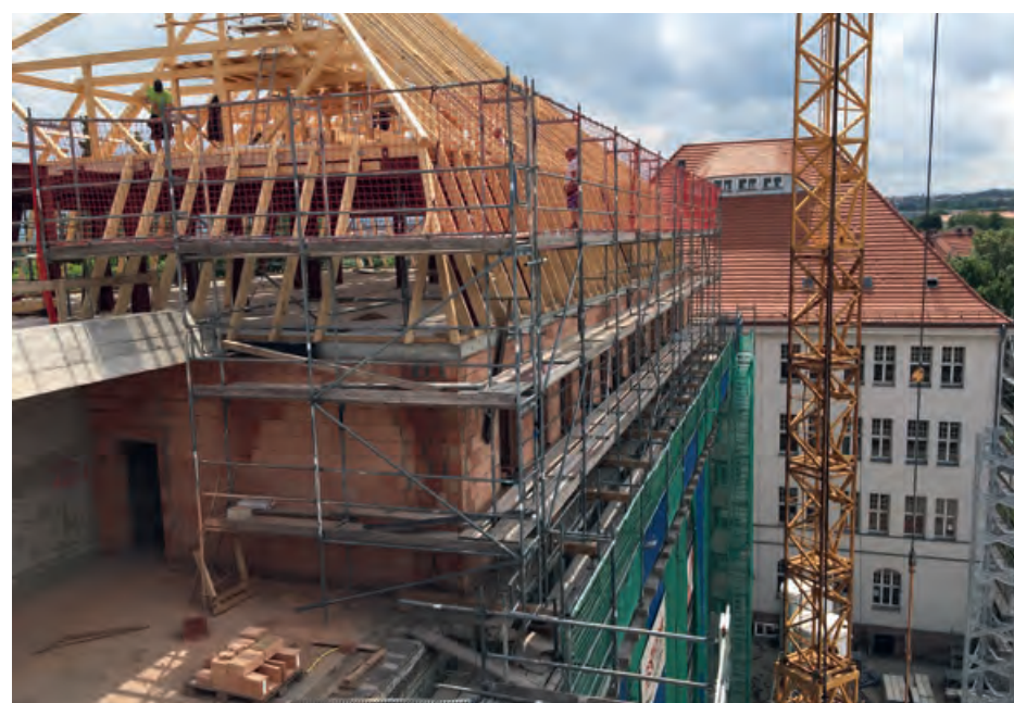
← Der Dachstuhl des Mittelflügels wurde nach dem Krieg nur notdürftig wiederhergestellt. Heute stimmt er bezüglich Geometrie und Dachdetails wieder weitestgehend mit dem Originaldachstuhl überein
