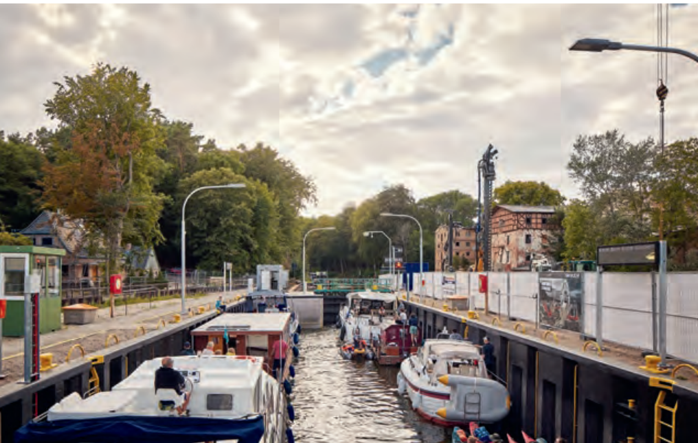
Zwischen dem Röblinsee und dem Menowsee fließt die Havel an der Steinhavelmühle vorbei. Die dortige Staustufe mit Schleuse und Wehr ist jetzt wieder voll funktionsfähig.
