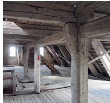
↑ Blick in den historischen Dachstuhl
