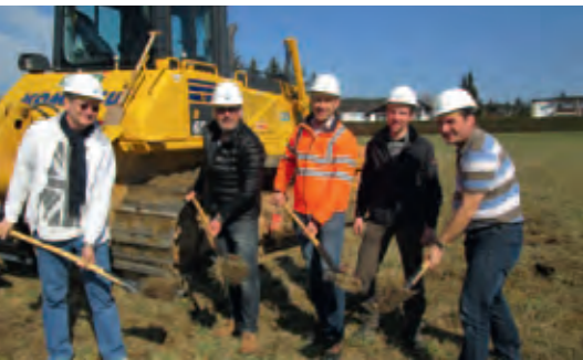
Offizieller Spatenstich für die neue Halle und das Rollenlager der Rondo Ganahl AG
