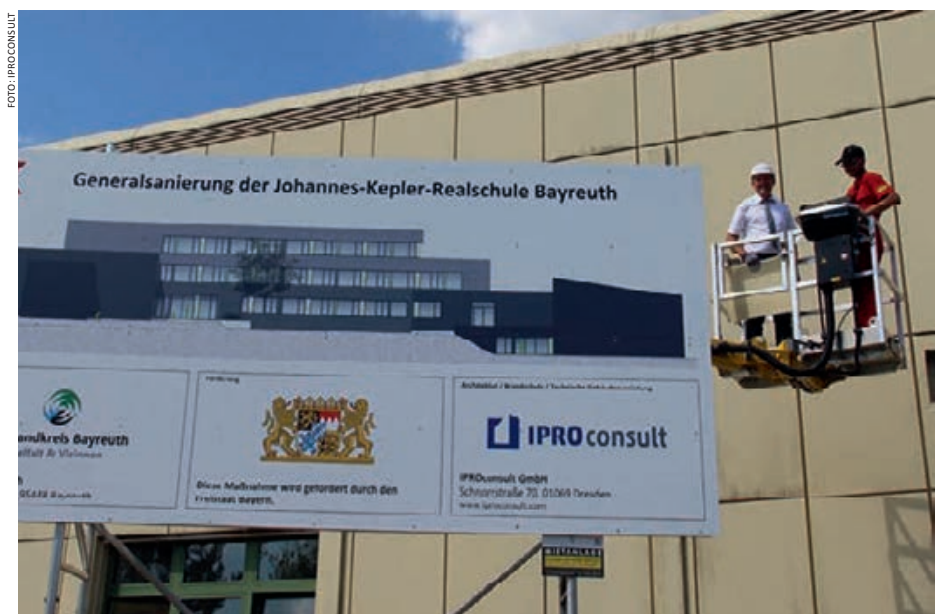
Eine grundlegende energetische Sanierung des Schulgebäudes ist nötig, dabei soll der Schulbetrieb möglichst ungestört weiterlaufen: eine Herausforderung für Planer und Baufirmen
