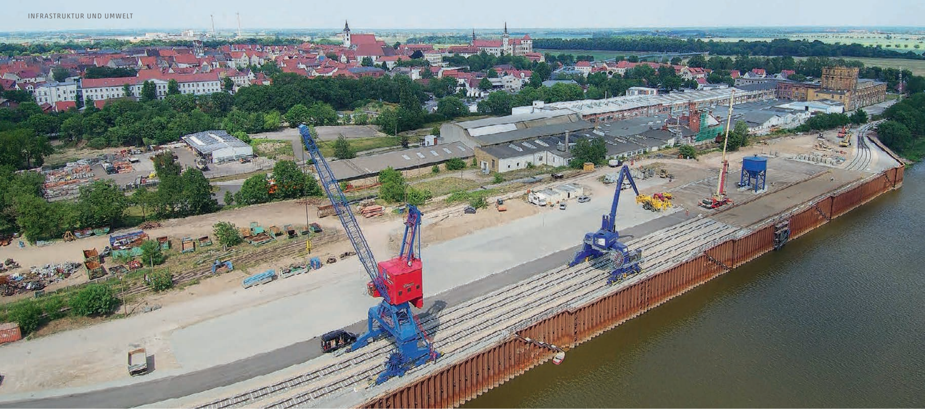
Im neuen Torgauer Hafen können Güter zwischen den drei Verkehrsträgern Wasser, Schiene und Straße umgeschlagen werden
