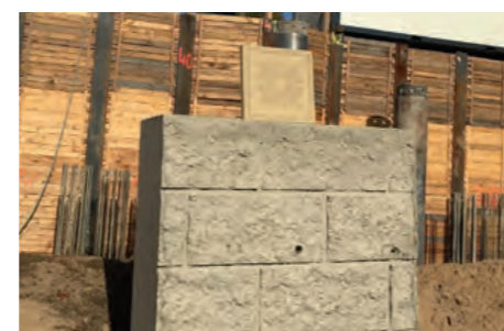
↑ Auf 226 Metern erstreckt sich die Mauer entlang der Planstraße Ost. Sie dient zum Ausgleich der Höhendifferenzen von bis zu fünf Metern
