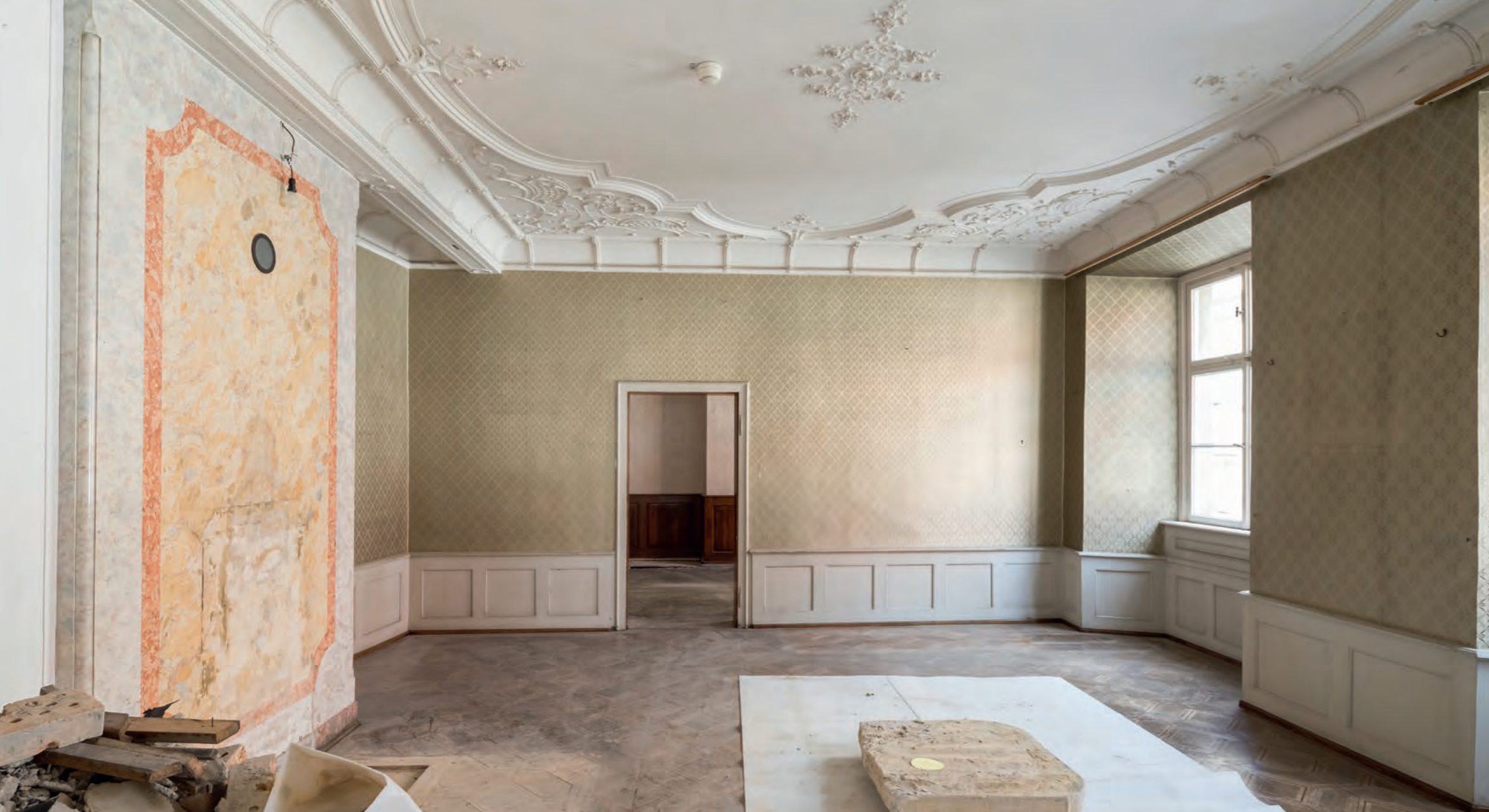
← Im Obergeschoss ist eine Deckenfläche mit umlaufenden Hohlkehlen im Neurokokostil stuckiert
