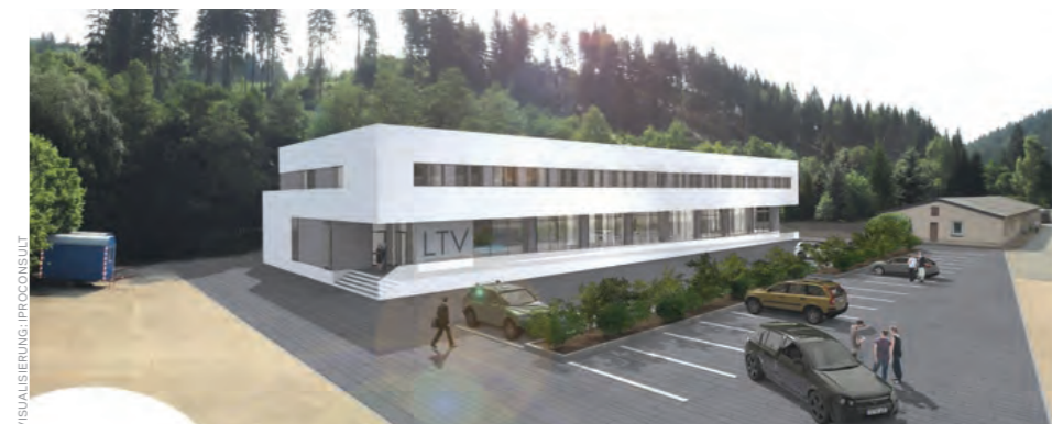
Die dreidimensionale Visualisierung ist auch ein Ergebnis der Planung nach der Methode BIM
