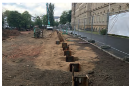
↑ Auf 226 Metern erstreckt sich die Mauer entlang der Planstraße Ost. Sie dient zum Ausgleich der Höhendifferenzen von bis zu fünf Metern
