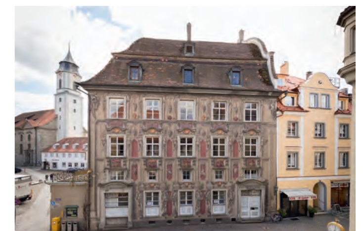
↑ Mit geschwungenem Mansarddach und opulenter Fassadenbemalung zählt der Cavazzen zu den wichtigsten Baudenkmalern der Lindauer Altstadt
