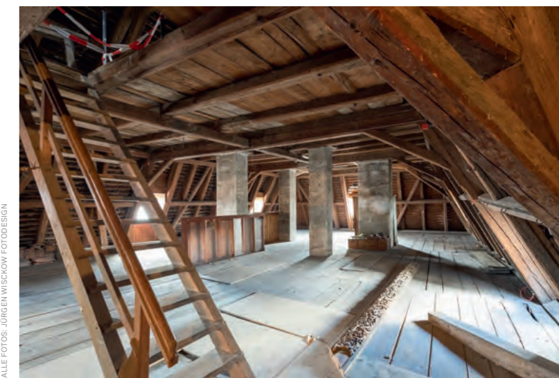
↑ Die Ebene zum zweiten Dachgeschoss wird teilweise zurückgenommen, um den Besuchern die Dachkonstruktion als Museumsstück zu zeigen
