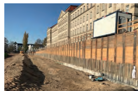
↑ Auf 226 Metern erstreckt sich die Mauer entlang der Planstraße Ost. Sie dient zum Ausgleich der Höhendifferenzen von bis zu fünf Metern
