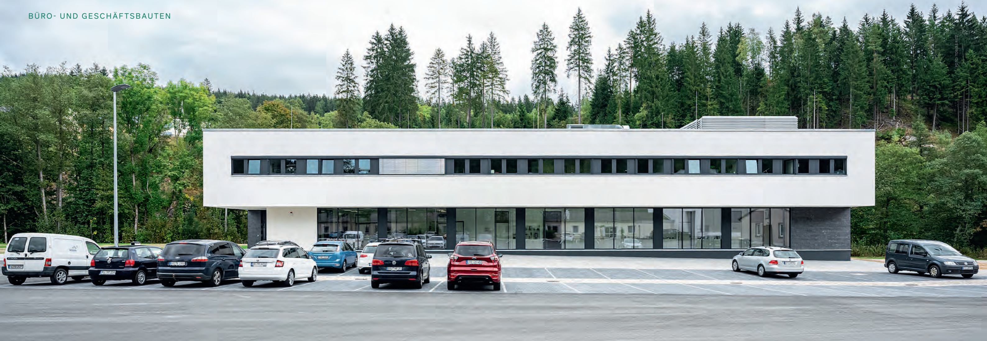
↑ Die Fassade bekam eine klare waagerechte Struktur aus weißen Putzflächen und dem im Erzgebirge typischen Schiefer
