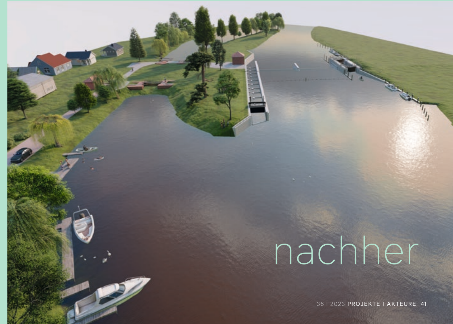
↓ Ersatzneubau von Schleuse, Wehr und neuer Fischaufstiegsanlage. Die historische Schleuse in Alt-Schadow von 1912 wird erhalten, aber zugeschüttet.
