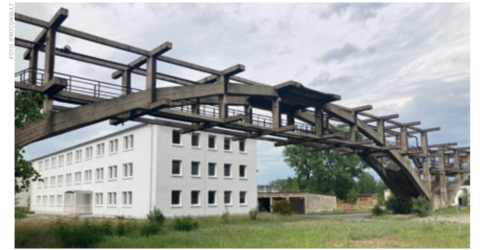
↑ Das ehemalige Verwaltungsgebäude aus den 1960er Jahren wird von IPROconsult Lausitz saniert, energetisch ertüchtigt und schließlich für eine funktionale Büronutzung hergerichtet.
