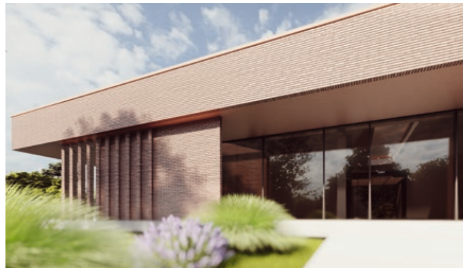
↓ Der umlaufende Umgang stellt den barrierefreien Zugang und den zweiten Rettungsweg sicher.
