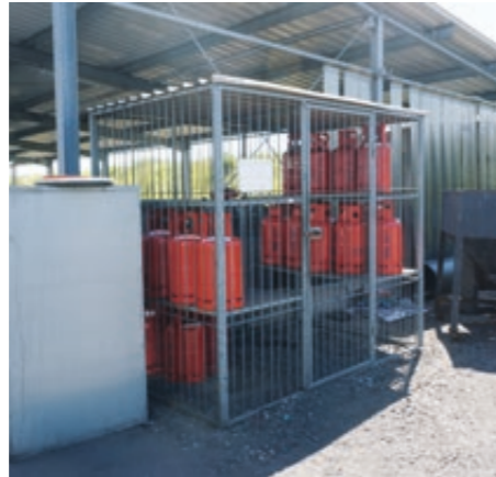
↑ Das Propangaslager befindet sich im Außenbereich.
