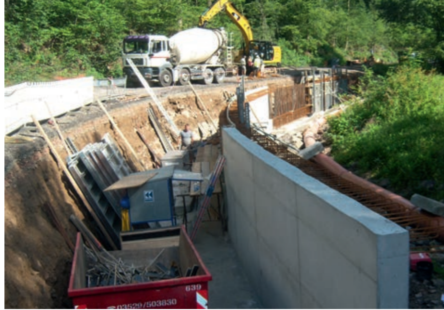
Die Gründung der Stützmauer zum Bachlauf stellte eine Herausforderung dar
