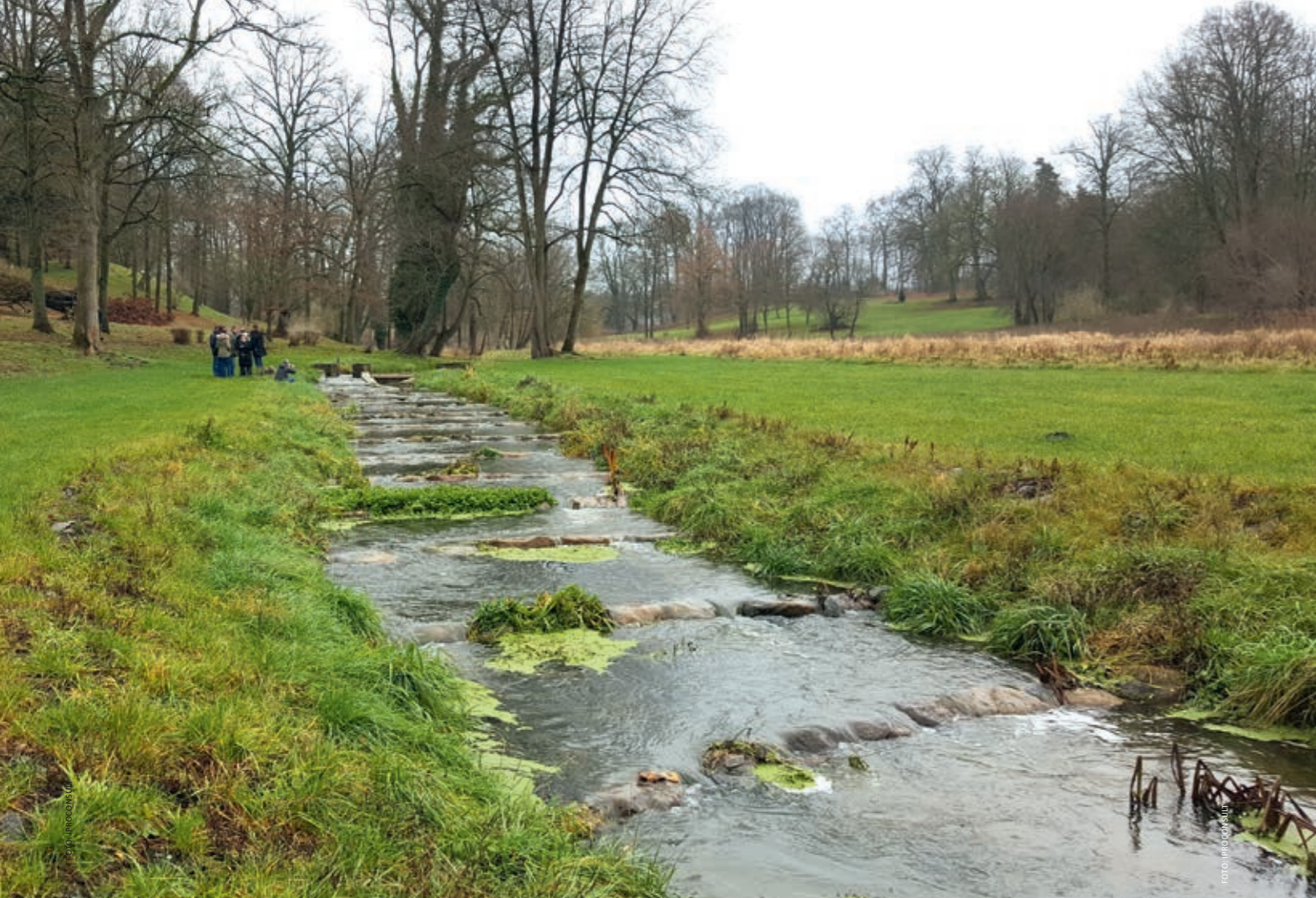
Derartige Fischtreppe erleichtern der in Fließgewässern lebenden Fauna das Wandern stromauf- und -abwärts
