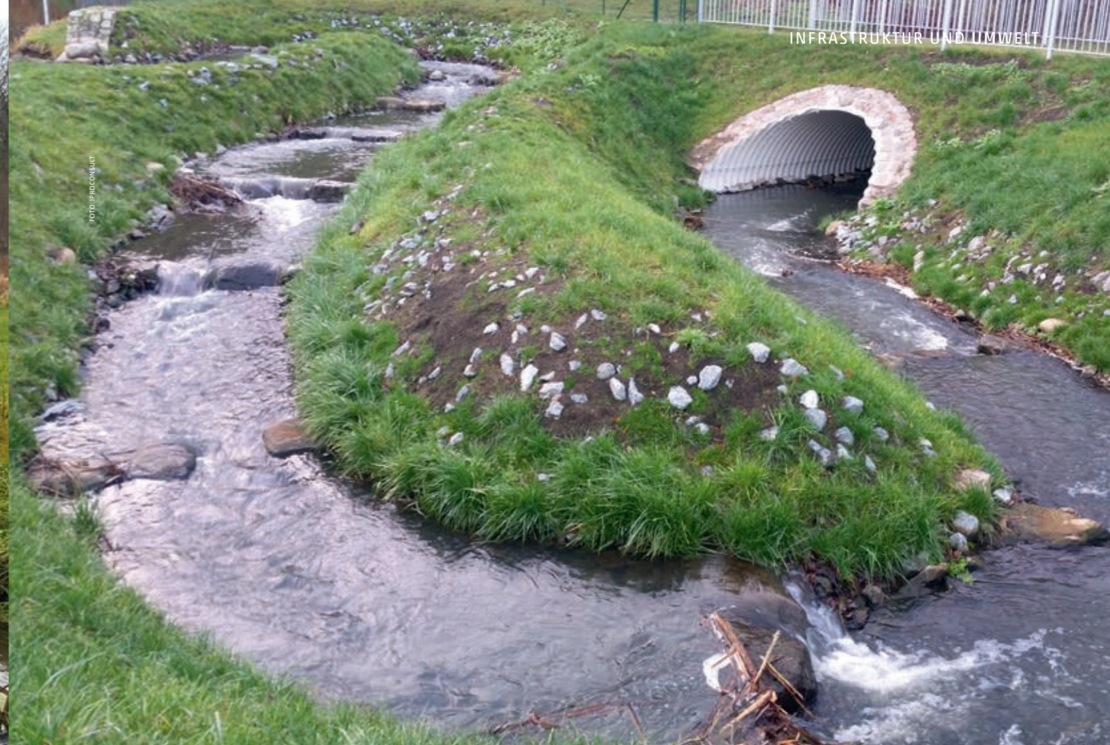
Fischaufstiegsanlagen können in der Fläche und bei der Erstellung erhebliche Dimensionen annehmen
