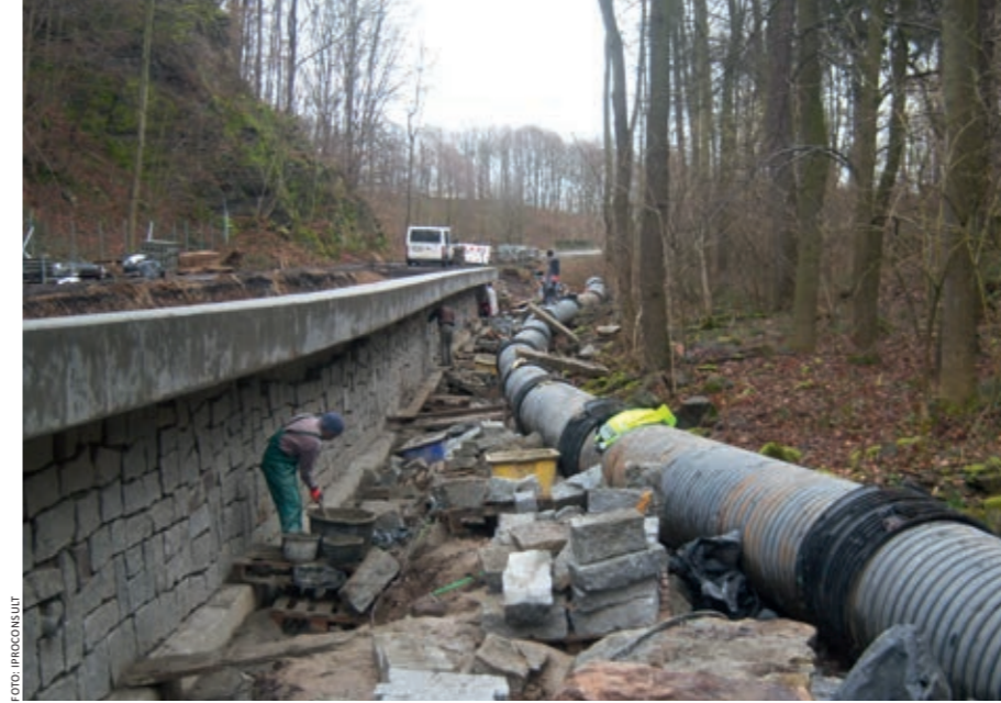
Während des Baus musste der Bach durch eine Rohrleitung geführt werden
