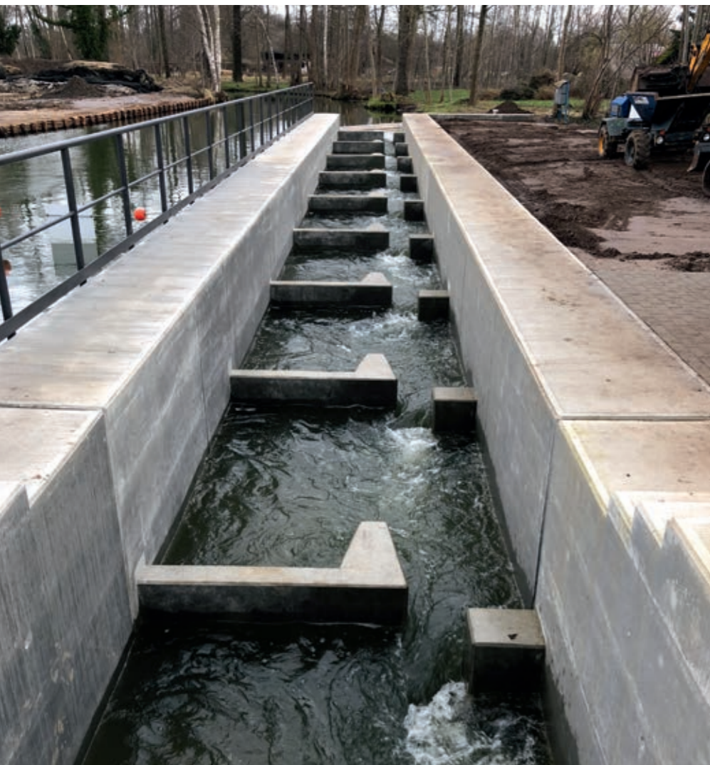
Fischaufstiegsanlage im Spreewald
