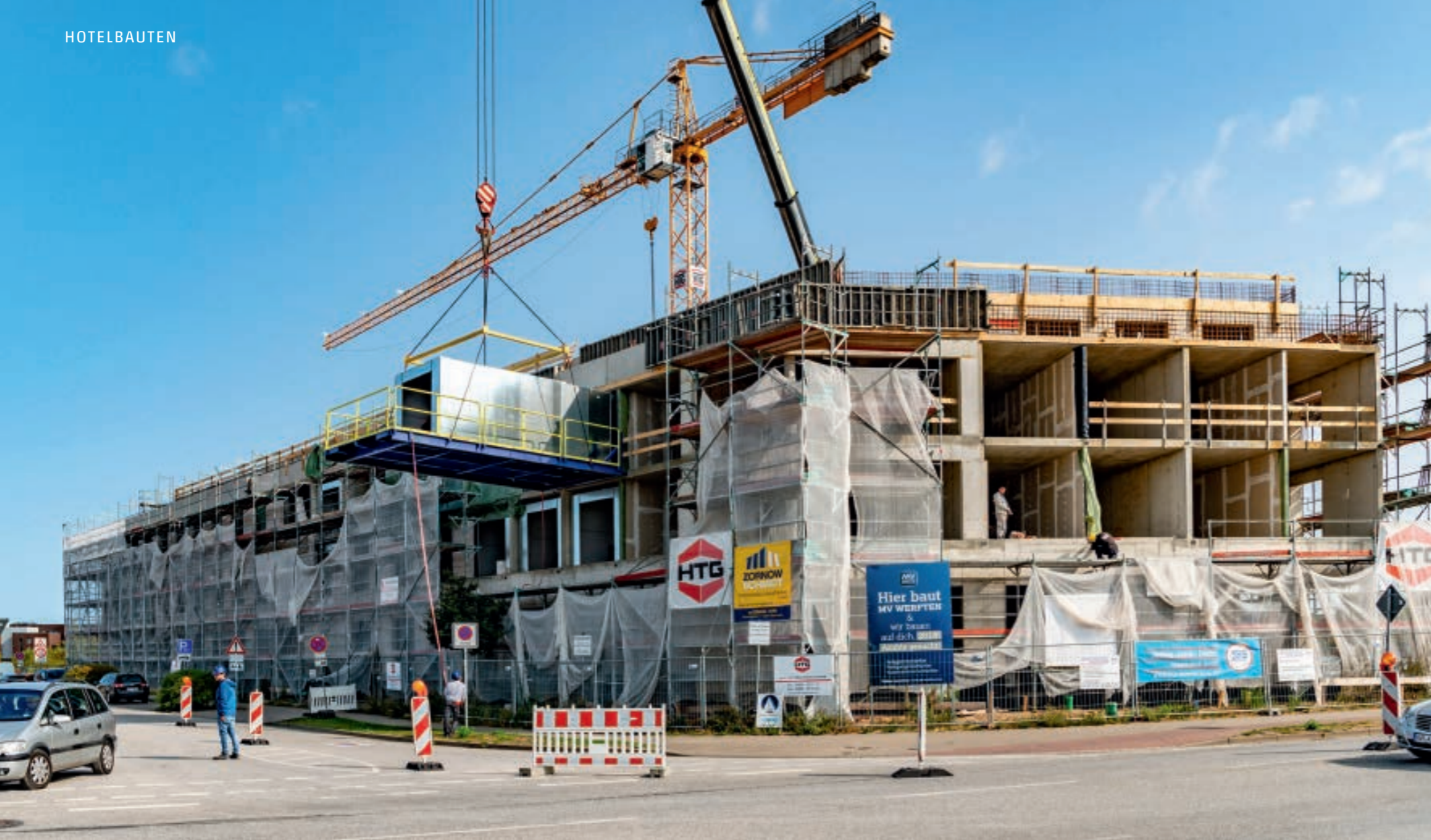
Die Gästezimmer der Herberge sind Schiffskabinen: Sie wurden vorher gefertigt und in den Rohbau eingeschoben
