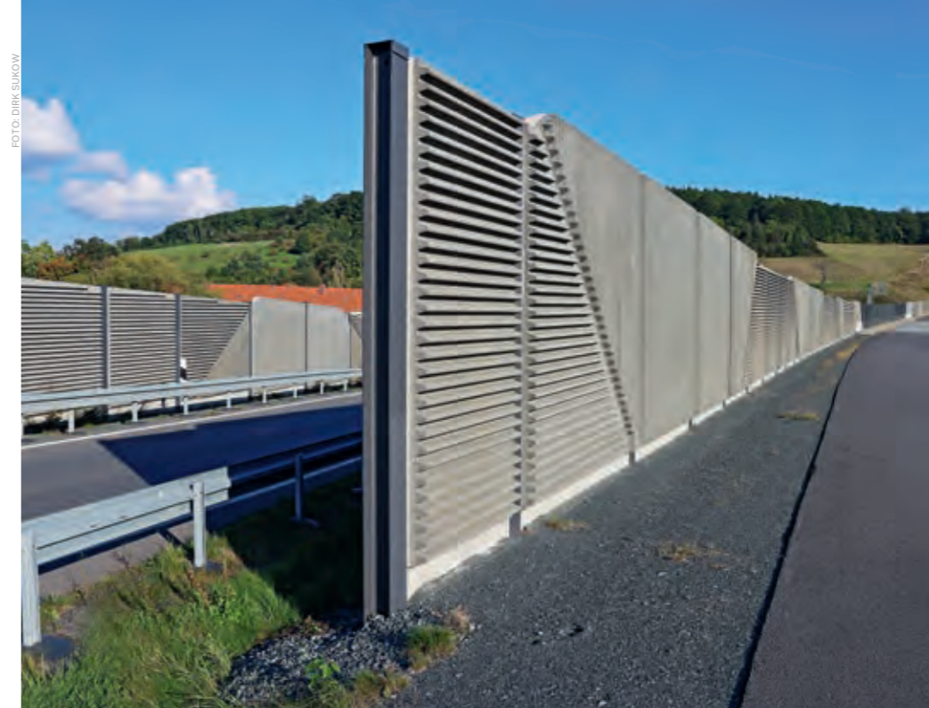
→ Die geforderten Gestaltungselemente in Form horizontaler Wellen auf den Lärmschutzwänden wurden in Absorptionsbeton realisiert.
