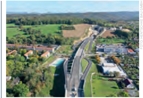
FOTO: HEINTSCHNE BAU GMBH
