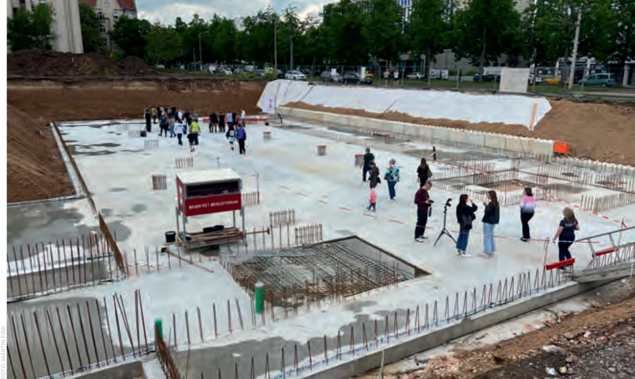
↑ Zur Grundsteinlegung war die Basis mit der Betonplatte bereits geschaffen.
