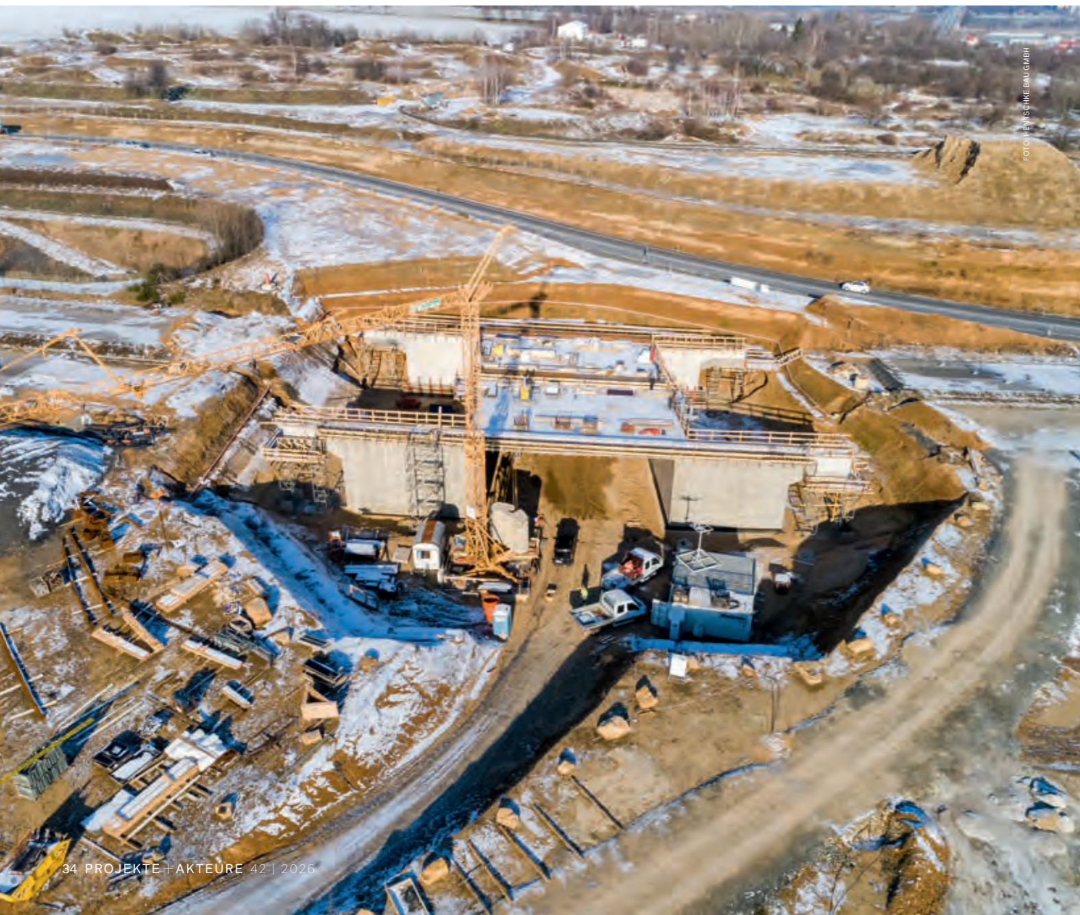
↓ In einer großen Kehrschleife unterquert der Abzweig die Bundesstraße in einem von IPROconsult geplanten Brückenbauwerk.
