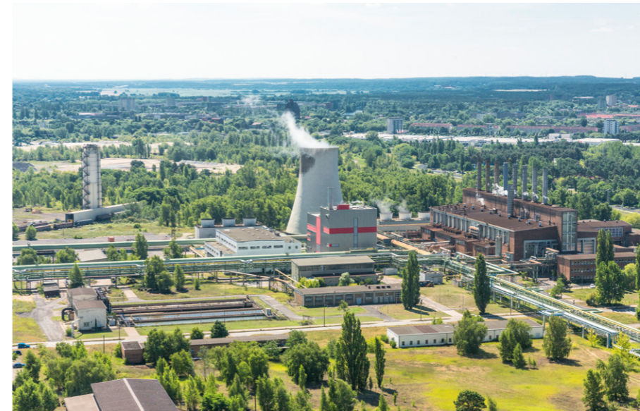
Gesamtanlage mit neuem (links) und altem (rechts) Kraftwerksblock
