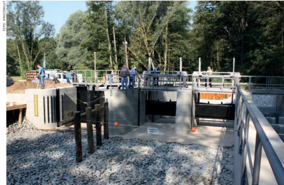
Das Wehr 100 liegt im Spreewald bei Flusskilometer 5,187 im Großen Fließ, in der Nähe der Polenzschänke.
