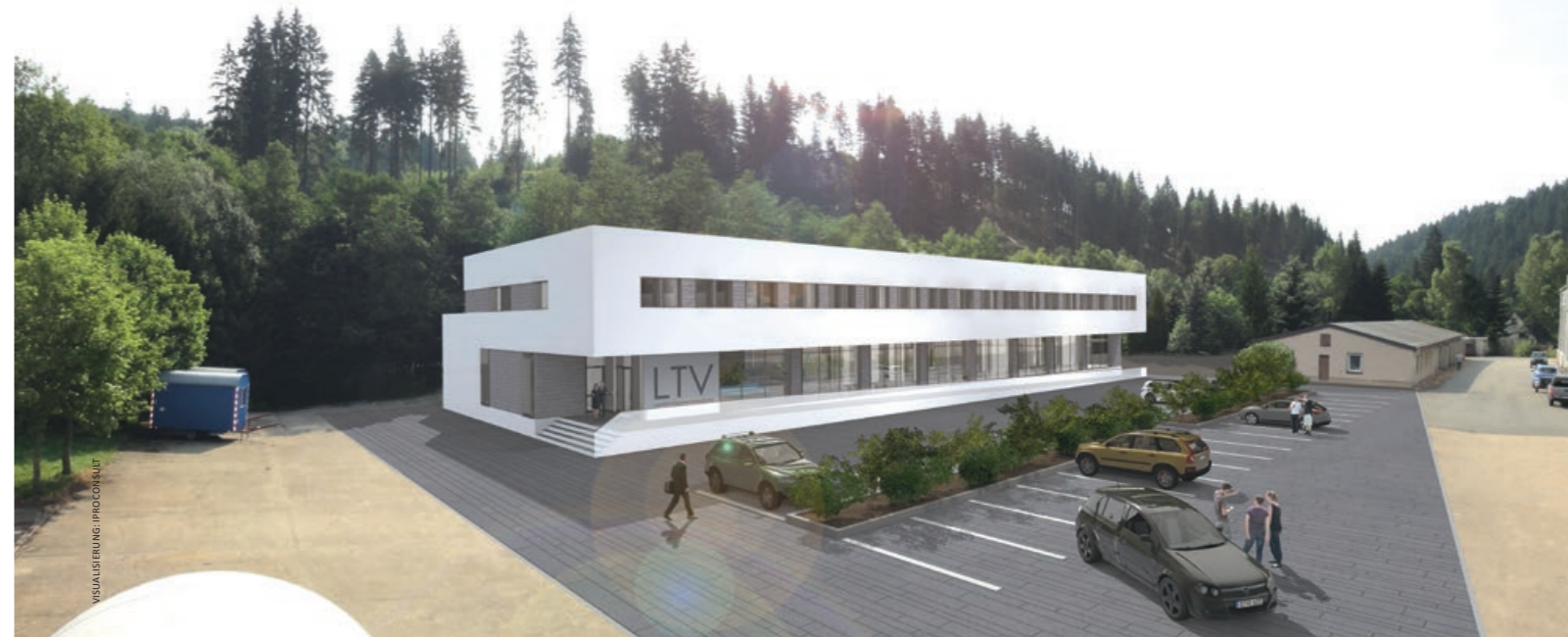
Der Neubau der sächsischen Landestalsperrenverwaltung im Erzgebirge wird als Pilotprojekt für die BIM-Planung genutzt.
