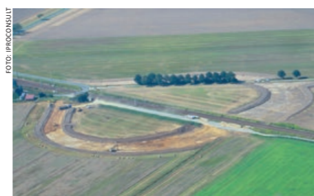
Die neuen Konturen der Straßenüberführung Brenitz
