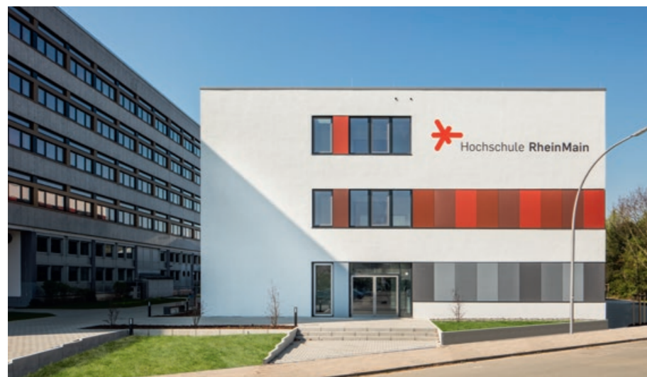
IPROconsult realisierte einen kostengünstigen, energieeffizienten Massivbau
