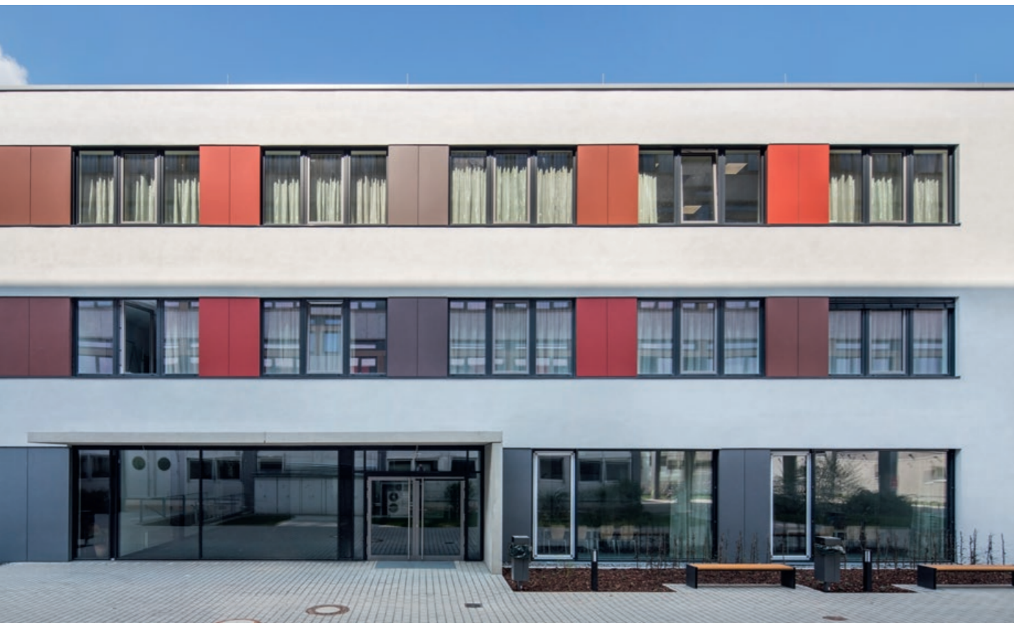
Das Gebäude erhielt eine Lüftungsanlage mit sehr hoher Wärmerückgewinnung und adaptiver Kühlung
