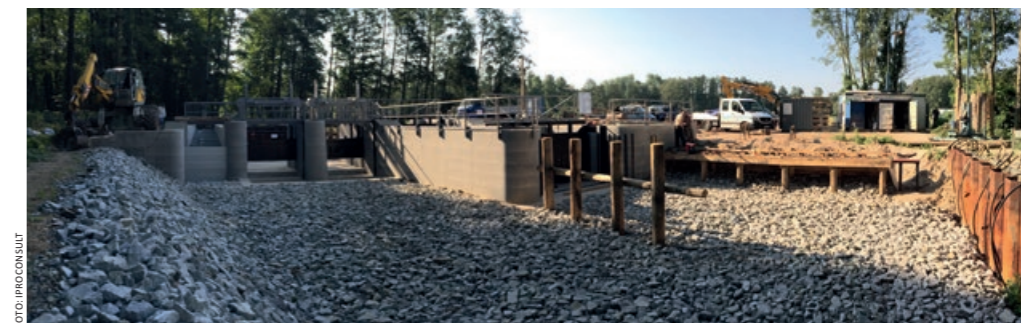
Der Bau der Wehranlage 100 erfolgte in einem Abschnitt. Das Große Fließ wurde dafür voll gesperrt
