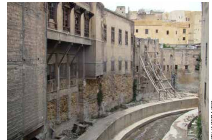
Sicherungs- und Restaurierungsarbeiten alter Bausubstanz am Rande der Medina von Fes
