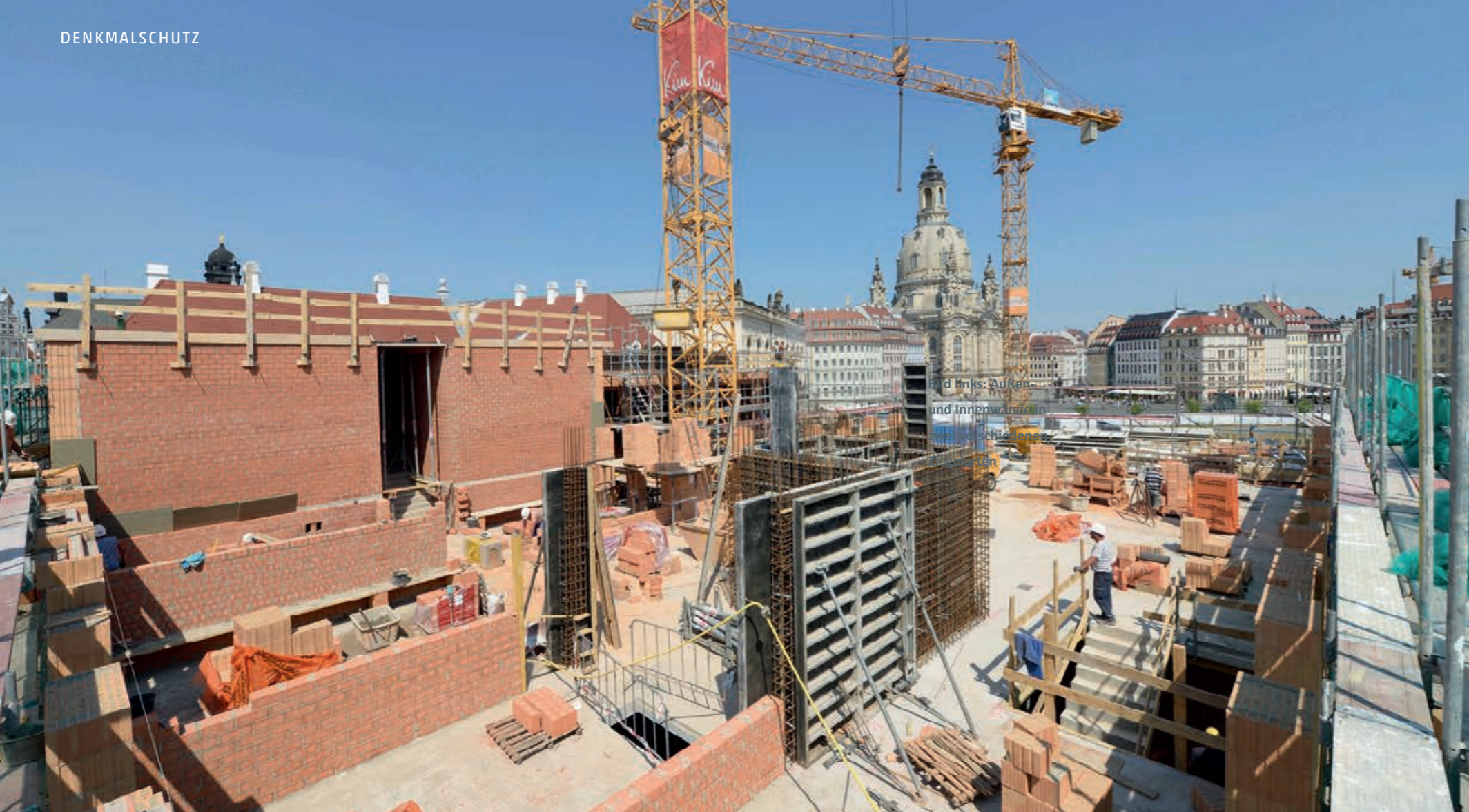
Außen- und Innenwände des Judenhofes entstanden in zwei verschiedenen Ziegelarten
