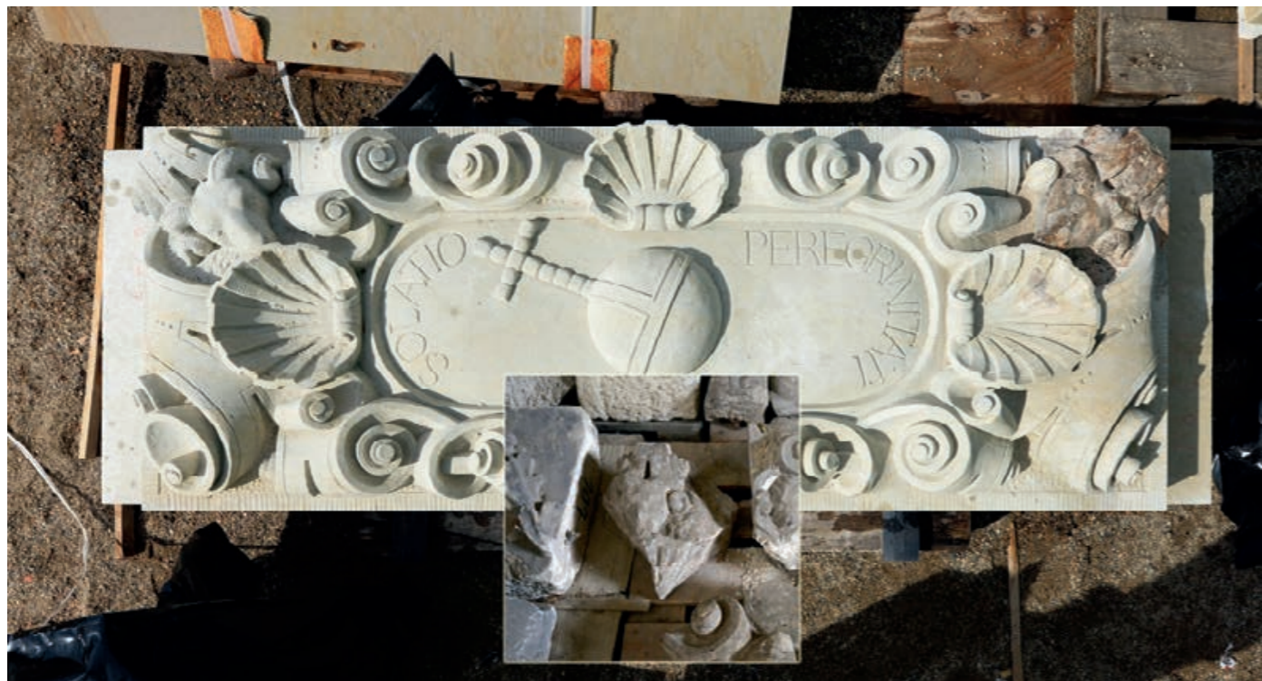
Brüstungsdetail mit eingebautem Fundstück für den komplett aus Sandstein errichteten Erker
