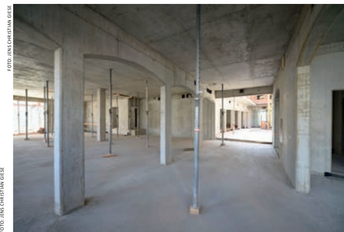
Das Erdgeschoss wurde in Beton ausgeführt und nimmt die historische Grundrissstruktur mit Pfeilern und Gewölbeadaption auf.
