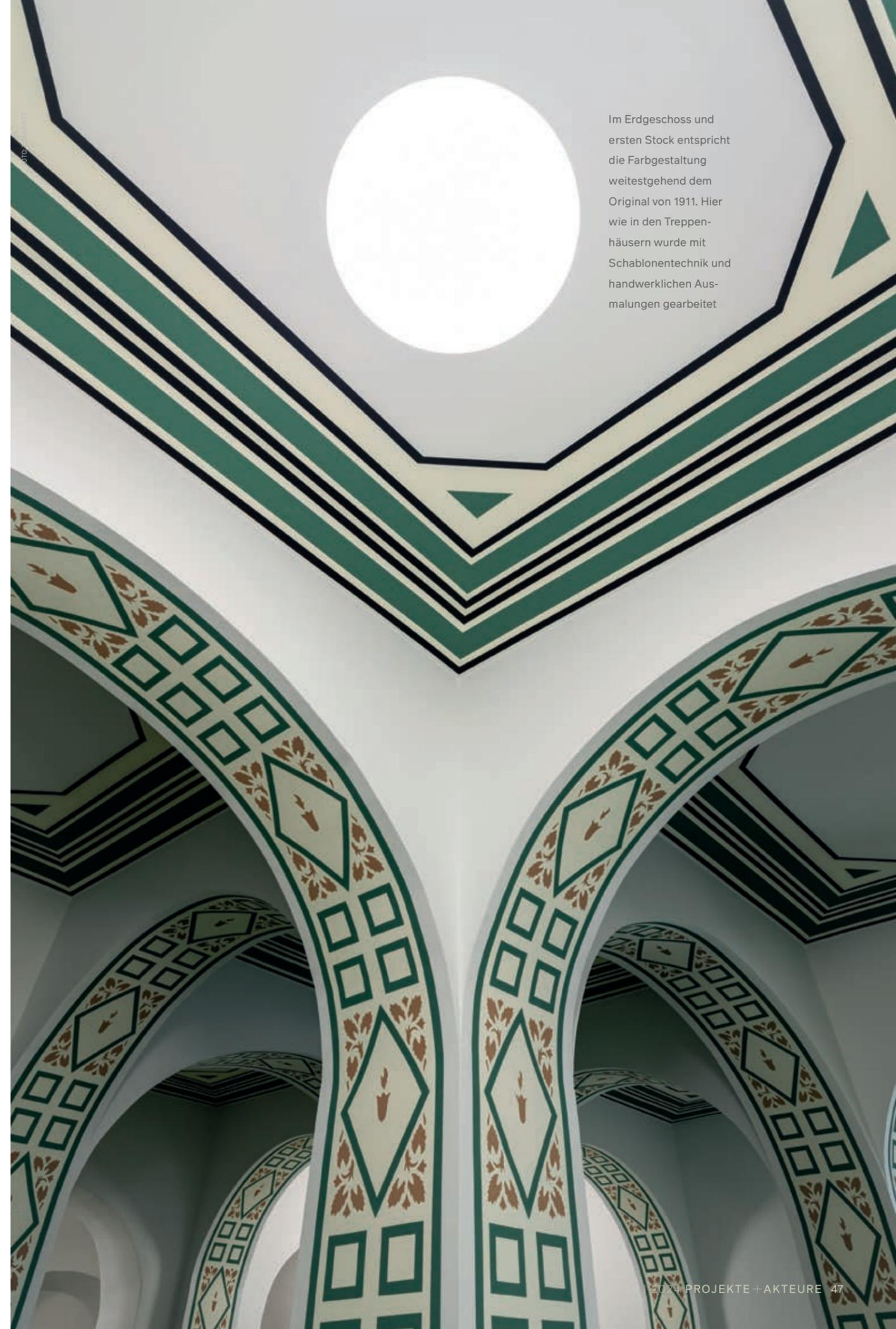
Im Erdgeschoss und ersten Stock entspricht die Farbgestaltung weitestgehend dem Original von 1911. Hier wie in den Treppenhäusern wurde mit Schablonentechnik und handwerklichen Ausmalungen gearbeitet
