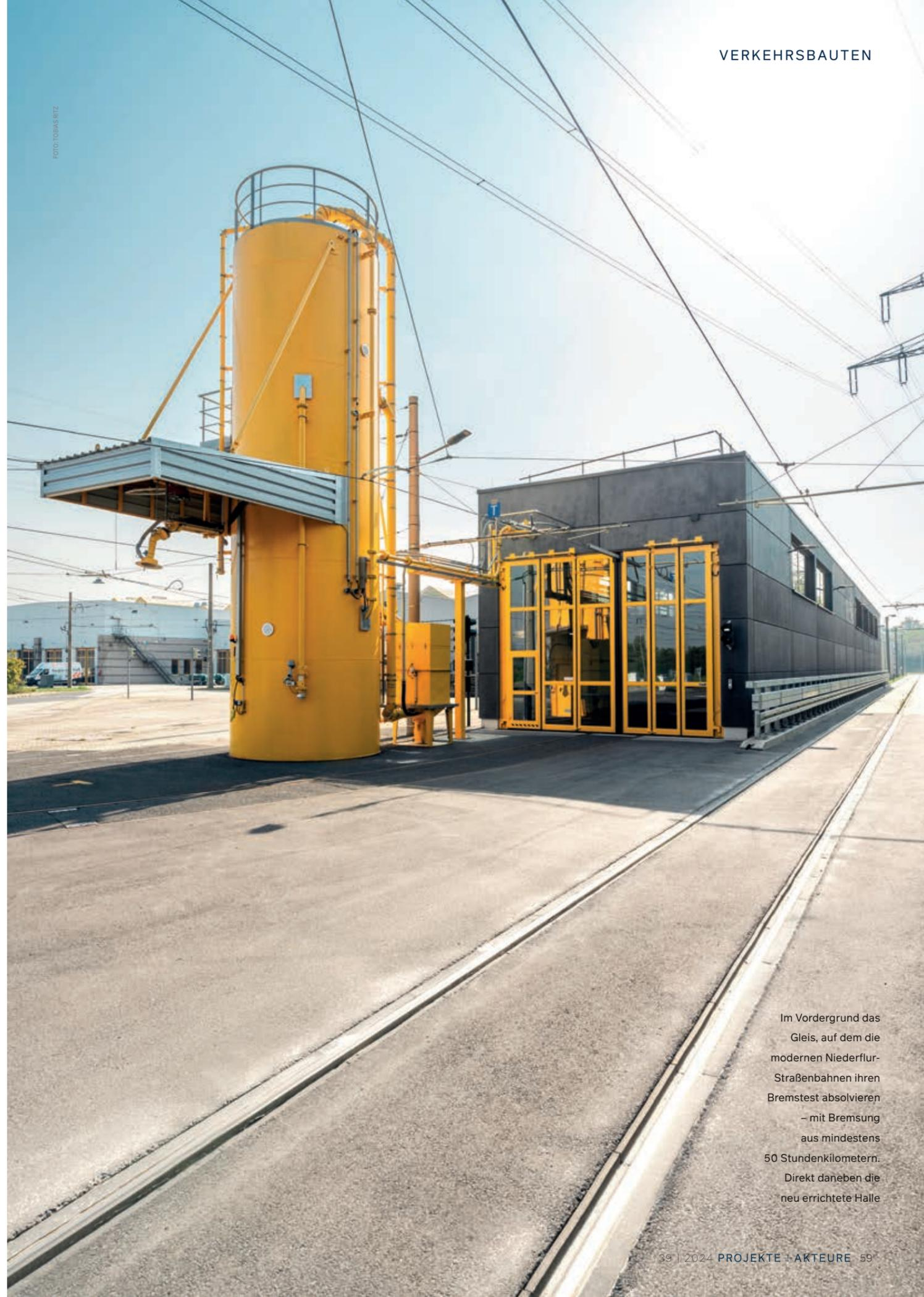
Im Vordergrund das Gleis, auf dem die modernen Niederfler-Straßenbahnen ihren Bremsstest absolvieren – mit Bremsung aus mindestens 50 Stundenkilometern. Direkt daneben die neu errichtete Halle
